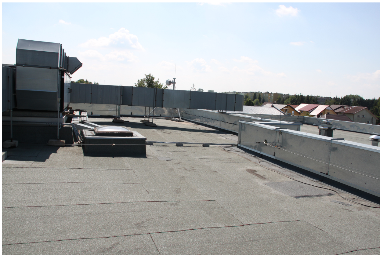
Fot nr 5-6 powierzchnia dachu kryta papa termozgrzewalną
