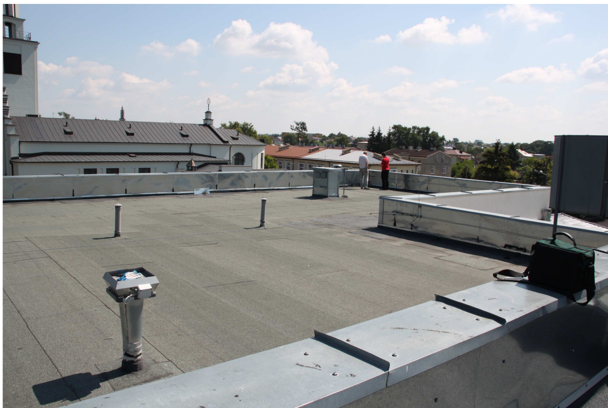
Fot nr 5-6 powierzchnia dachu kryta papa termozgrzewalną
