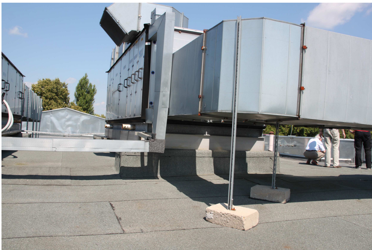
Fot nr 4 elementy wentylacyjne- podstawy do wyklejenia papa termozgrzewalną
